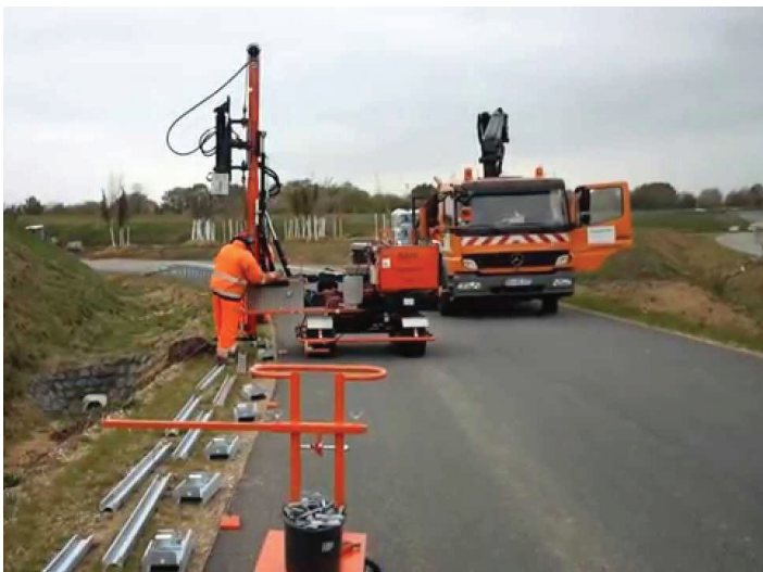
Набиване на мантинели в пътно строителство
